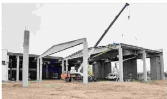
I macchinari Refrion davanti al Cineca, sotto il cantiere a Talmassons
